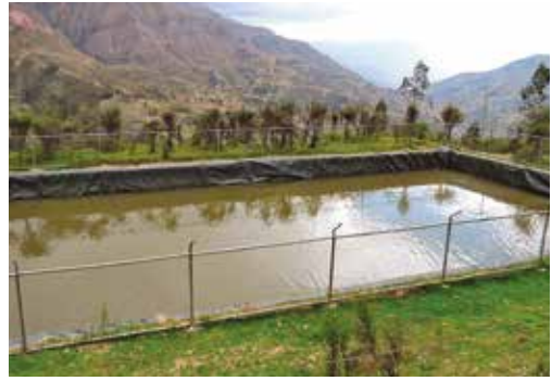
Figura 11. Reservorios mejorados con geomembrana de las comunidades de Estrellani (izquierda) y Jinchupaya (derecha) en Morochata
