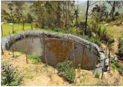
Figura 11. Reservorios mejorados con geomembrana de las comunidades de Estrellani (izquierda) y Jinchupaya (derecha) en Morochata
