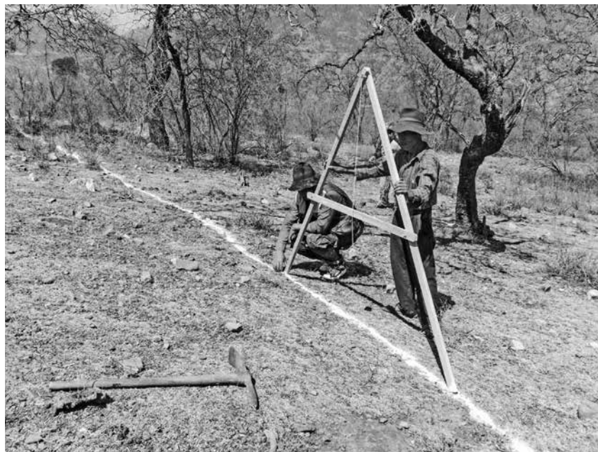
Fotografía 4. Utilización de Nivel A para garantizar un correcto trazado de la curva de nivel, de tal modo de lograr 0 de pendiente, con lo cual se logrará captar y retener el agua de escorrentía de la escasa lluvia que se presenta en la zona
